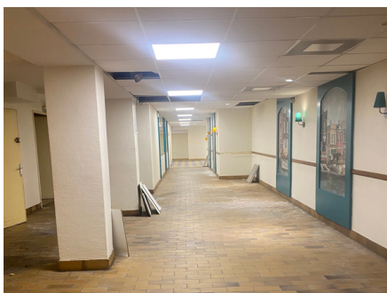
espace en sous-sol
